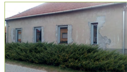
Egy folyamatban lévő átalakítás - a függőleges, hosszúkás ablakok miatt egészen hagyományos összképe lesz az épületnek; egyszerű megoldás, és még a szobákba is több fényt enged; s az ablak alá nem kell már gázkonvektort gyömöszölni, tehát lehet alacsonyabb a parapet. A „Kádárkockák” egyik fő baja a széles, lapos ablakok által meghatározott összkép; ez egy jó megoldás lesz erre a gondra.
