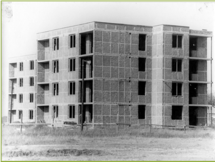
A Gólyás ház melletti téglablokkos ház építés közben.
