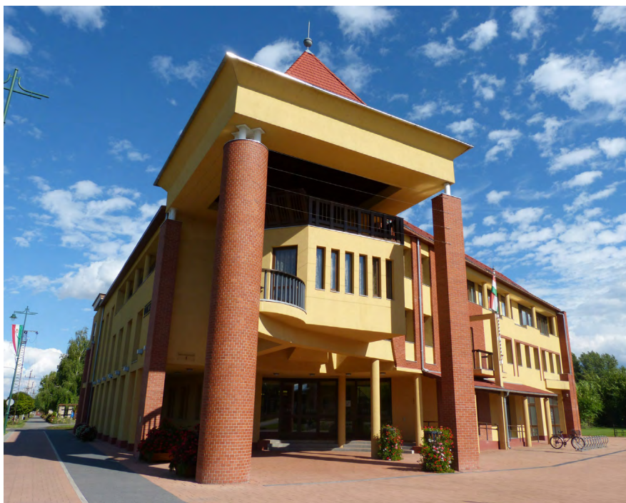
Az új városháza épülete
