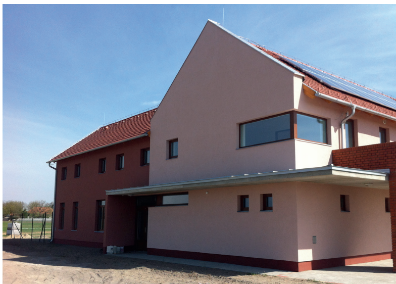
Az elkészült Termálfalu Községi Épület
